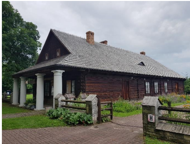
Fot. 3: MGOK w Solcu nad Wisłą 8
